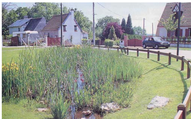
Noue engazonnée Opération Belbeuf – 76 Source Foncier Conseil
